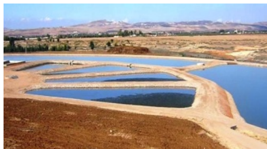
Figure 28 : Station d'épuration de Ain Taouajtate
