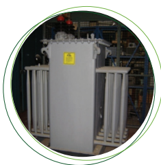
Appareils électriques à PCB
