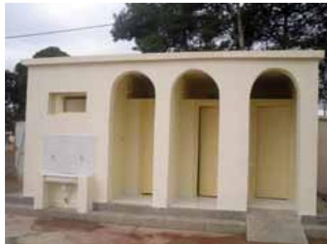
Sanitaires au niveau d'une école rurale
