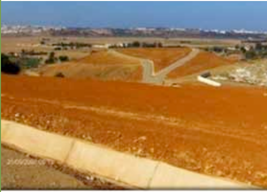
الشكل 27 : محطة معالجة مياه الصرف الصحي بتاوجطات
