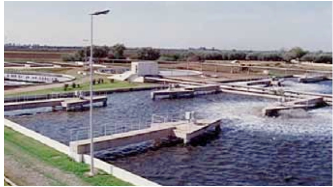
الشكل 26 : محطة معالجة المياه العادمة ببنجي ملال
