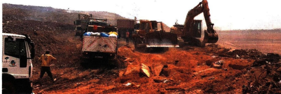
Les travaux d'exploitation quotidienne de la décharge de Médiouna comportent l'étalage, le compactage, le remodelage et le talutage des déchets. Autrement dit, l'enfouissement des déchets existants sur le site (Ph. L'Economiste)
