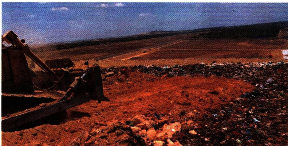
Les travaux d'exploitation quotidienne de la décharge de Médiouna comportent l'étalage, le compactage, le remodelage et le talutage des déchets. Autrement dit, l'enfouissement des déchets existants sur le site (Ph. L'Economiste)
